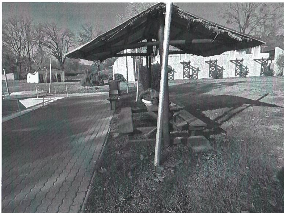
27. kép - pihenőpadról déli oldali fotó, a pad nyugati irányban is megbillent, talajon horpadás, süllyedés
