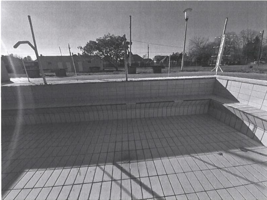
25. kép - pihenőmedence nyugati fala, repedések nem láthatók
