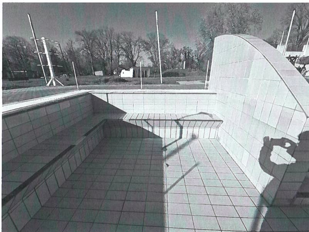
24. kép - pihenőmedence északi fala, a lépcsőtől nyugatra, repedések nem láthatók
