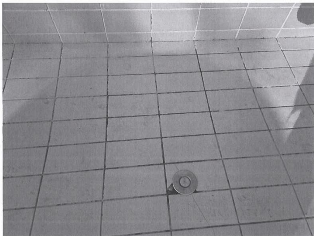
10. kép - gyerekmedence 1-es számú repedés közelebbi nézete, kisebb repedéstágasság mint 1mm
