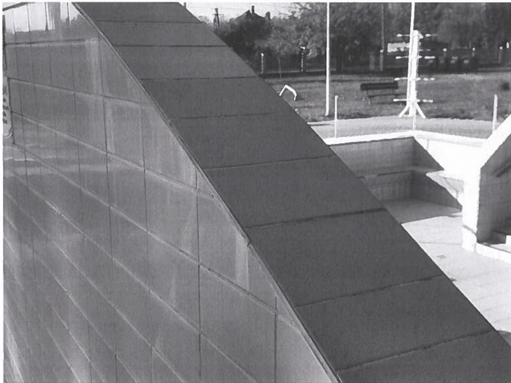
13. kép - a repedés a fal tetején, az eredeti burkoláshoz képest későbbi burkolaton már nem repedt át
