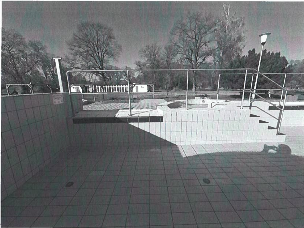
39. kép - tanmedence északi fal, repedések nem láthatók
