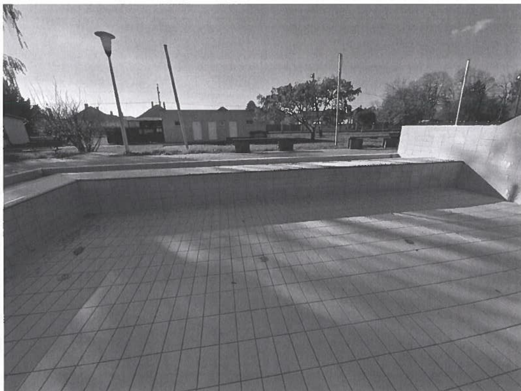
5. kép - gyerekmedence nyugati fala, repedések nem láthatók
