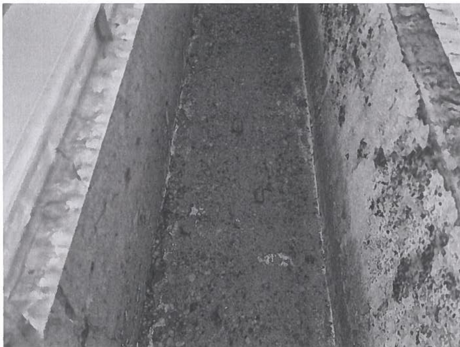
1. kép - folyóka általános nézete, valószínűleg a folyóka alsó betonrétege javításra szorul
