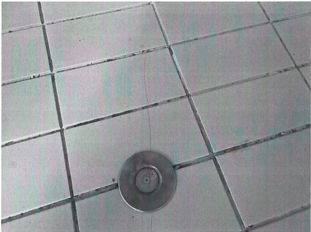
15. kép - 3-as számú repedés közelebbi képe, kisebb repedéstágasság mint 1mm
