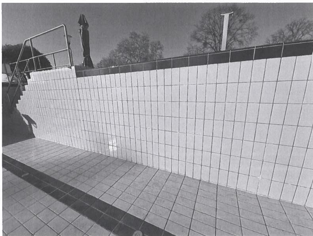
34. kép - úszómedence északi fala, repedések nem láthatók
