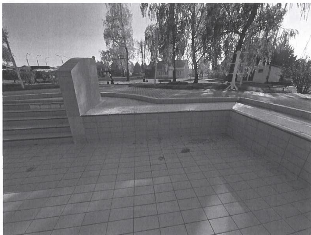
6. kép - gyerekmedence déli fala, a lépcsőtől nyugatra, repedések nem láthatók
