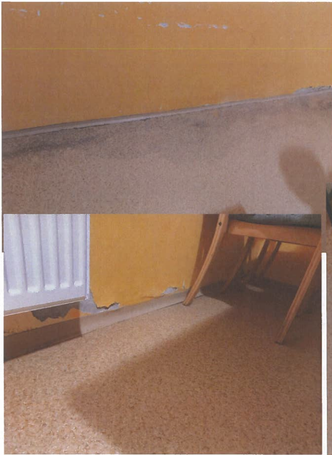
NMI-iroda falvizesedés, a vizesedés miatt a műanyagpadló penészesedés
