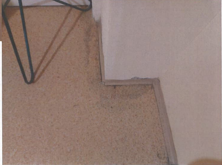
NMI-iroda falvizesedés, a vizesedés miatt a műanyagpadló penészesedés
